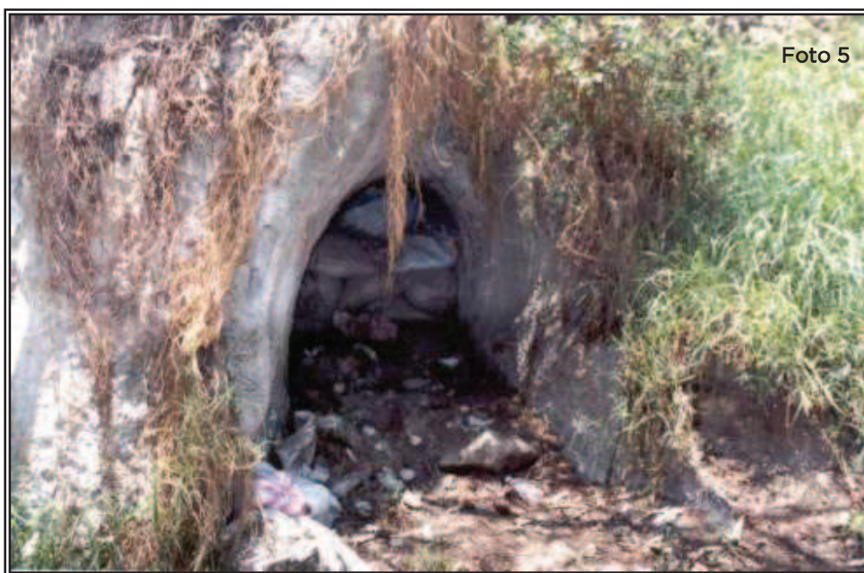
Foto 5. Entrada de túnel en la obra minera de El Chaparral, que se interpretó como el nivel más bajo de explotación. En su parte superior se encuentran viviendas correspondientes a la calle Ruiseñor.
