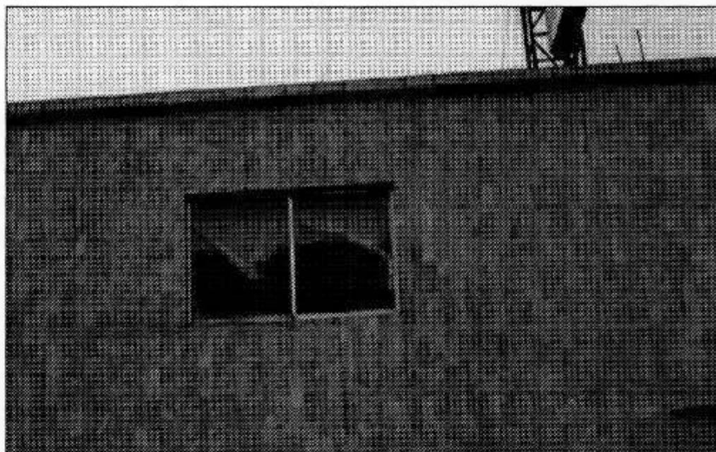
Para forzarlas se puede introducir una herramienta entre el marco y la ventana y hacer un movimiento de palanca para que se deslice rompiendo el seguro.
