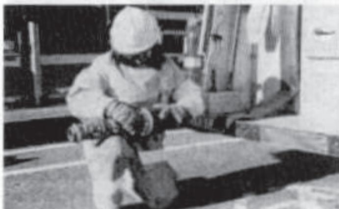
La conexión con los empalmes de acción rápida se hace de la misma manera, salvo que se realiza un cuarto de vuelta solamente.
