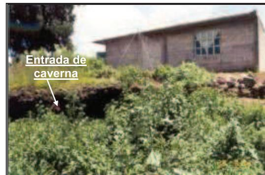
Foto 9. Entrada de una caverna, donde sobre el cielo de la misma, se edificó la vivienda.
